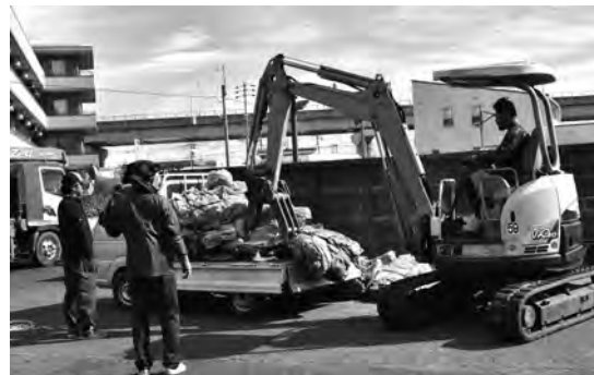
▲ 廃ビニールの回収
