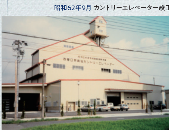
昭和62年9月 カントリーエレベーター竣工
