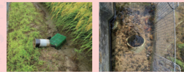
写真3. 取水口(右)、排水口(左)の網の設置例
